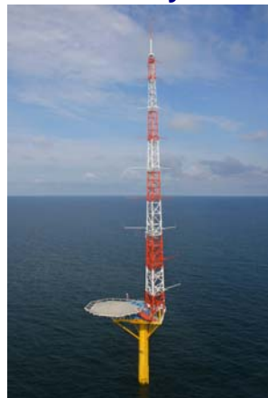
Die Plattform FINO3 in der Nordsee Quelle: FH Kiel
