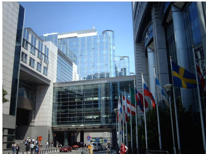
Das Gebäude des EP in Brüssel (Quelle Wikipedia)
